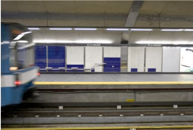
Deux ans seulement après son inauguration, la station de métro de la Concorde à Laval rejoint les rangs des stations «lépreuses» de Montréal avec ses murs dépouillés de tuiles et le béton à nu. Photo: Alain Roberge, La Presse
